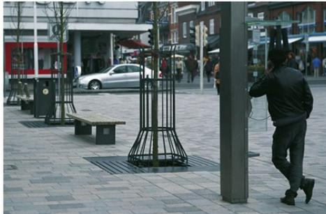
Betonplattenbeläge mit Granitplittvorsatz in verschiedenen Farben
